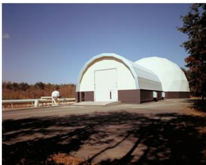
磁気測定室（ドーム） 消磁室 前室
