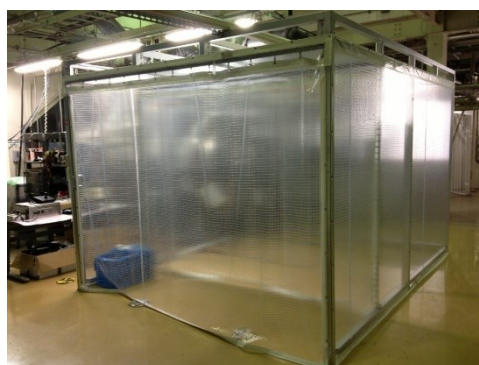
図2-9 クリーンブースの外観
